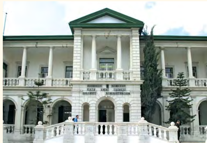
Les bureaux de l'Administration de district de Limassol.
