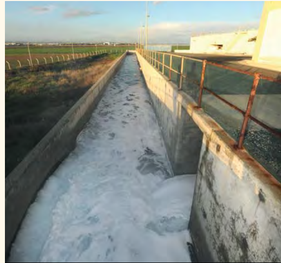
Usine de dessalement à Larnaca.
