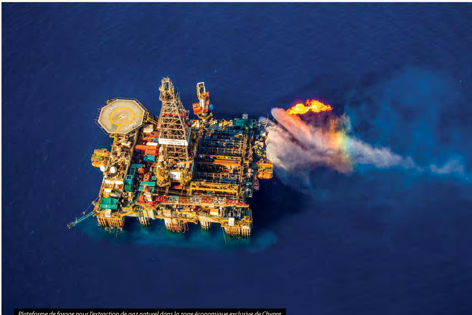
Plateforme de forage pour l'extraction de gaz naturel dans la zone économique exclusive de Chypre.
